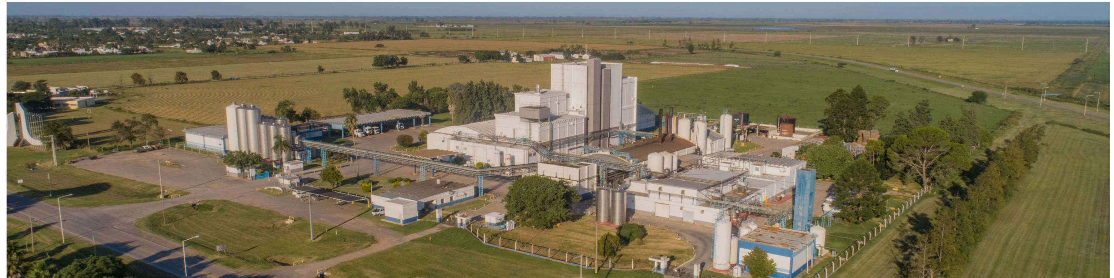
Nossa Planta de Morteros em Córdoba, Argentina.
